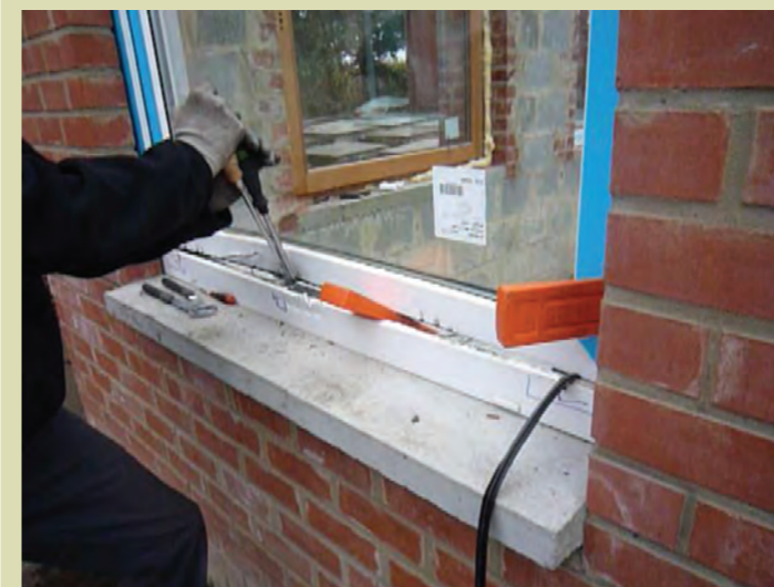
187 Bevestiging met schroef met dubbele draad.
