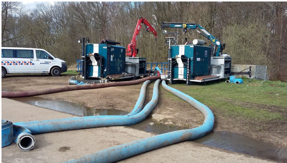
Figuur 29: opstelling van de pompen van de Civiele Bescherming aan de sifon van de Tappelbeek onder het Albertkanaal (13/03/2020)
