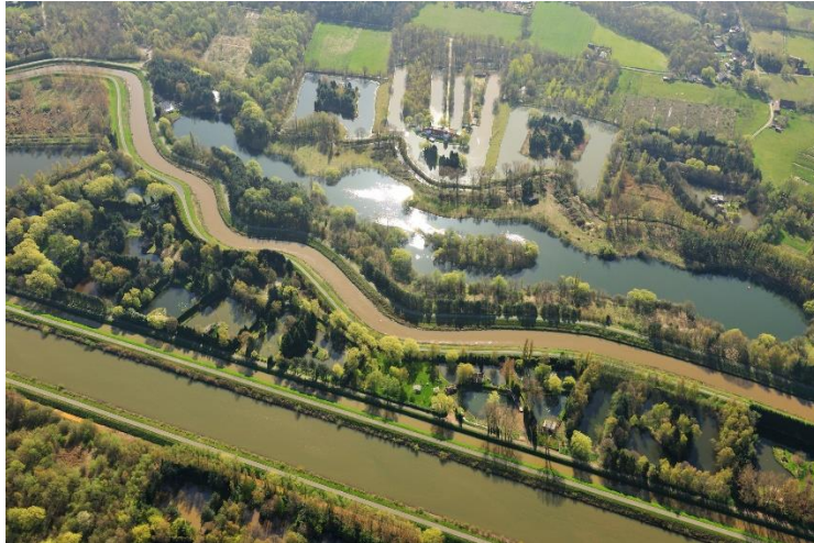
Luchtfoto van het gebied met de dragende structuren van het Netekaal en de Kleine Nete
