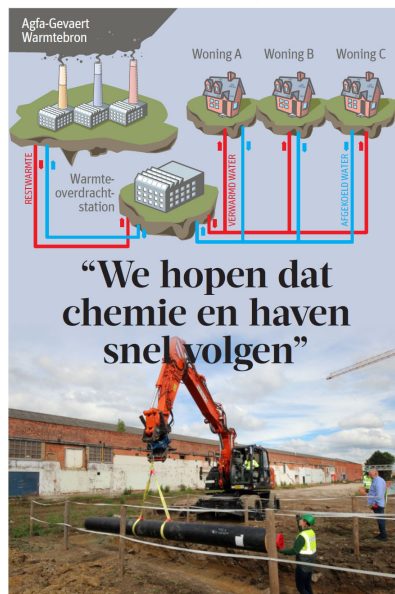
De eerste buis van het warmtenet wordt geplaatst. Foto: FILIP SPOELERS
